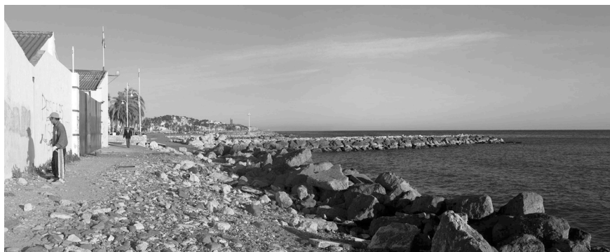
Figura 3. Fachada al mar de los astilleros Nereo.
