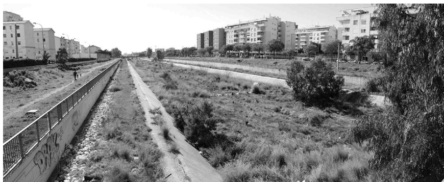
Figura 6. Cauce del río Guadalmedina.
